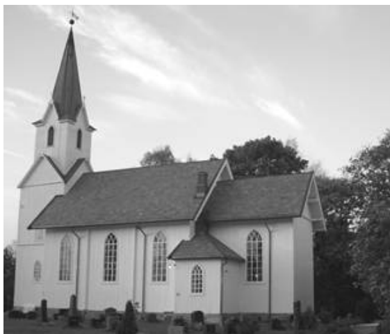
Garder kirke etter restauarering og oppussing sist sommer. Foto: Hans Pedersen
